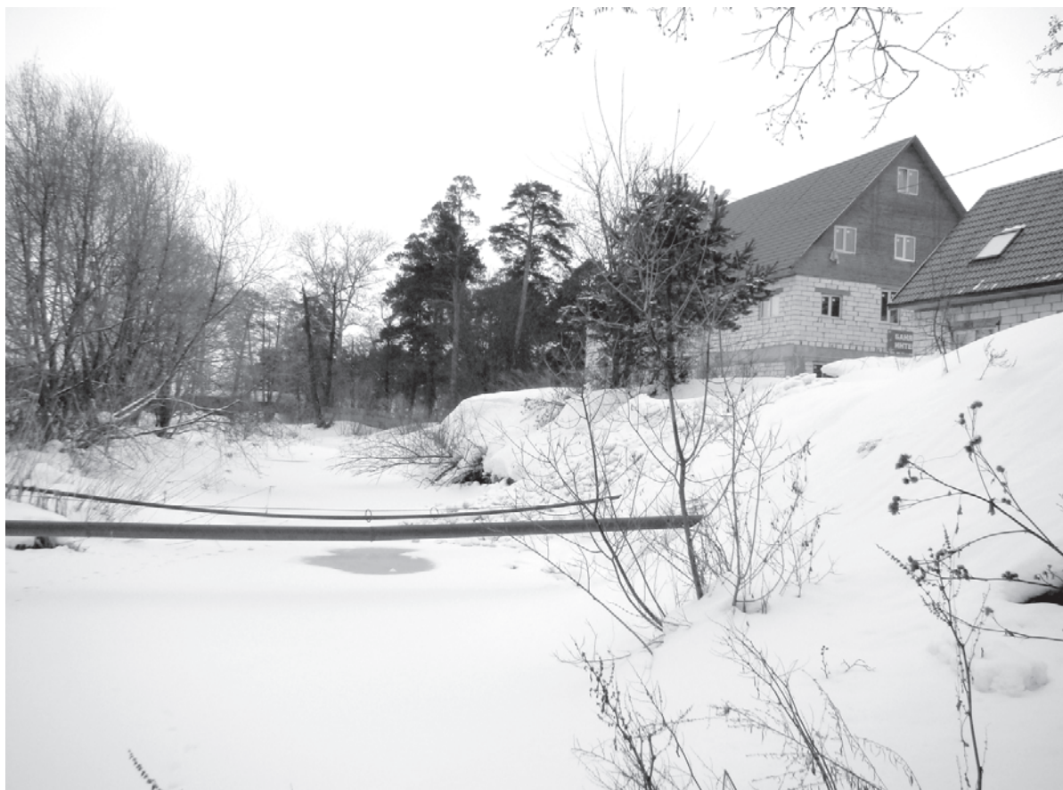
Вот так до недавнего времени провисали трубы холодной воды и канализации над речкой Черной...
