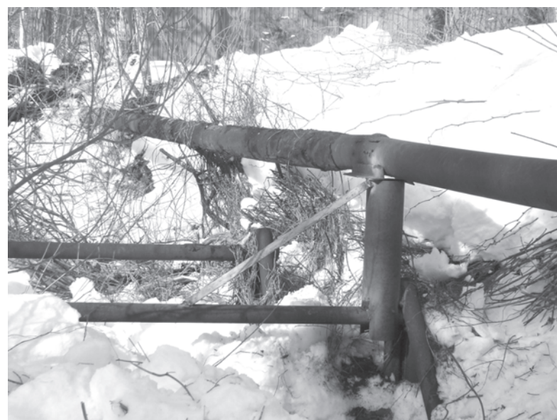
Вот так до недавнего времени провисали трубы холодной воды и канализации над речкой Черной...
